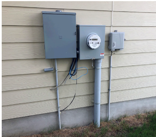
Conexión del Medidor Subterránea Típica
